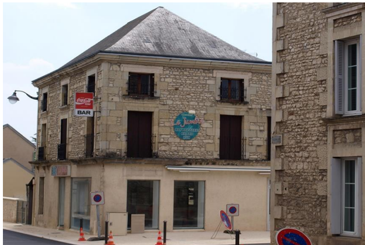
(Ph. 52) - Emplacement de travaux angle de la rue de Poitiers. (Ph. Ap)
